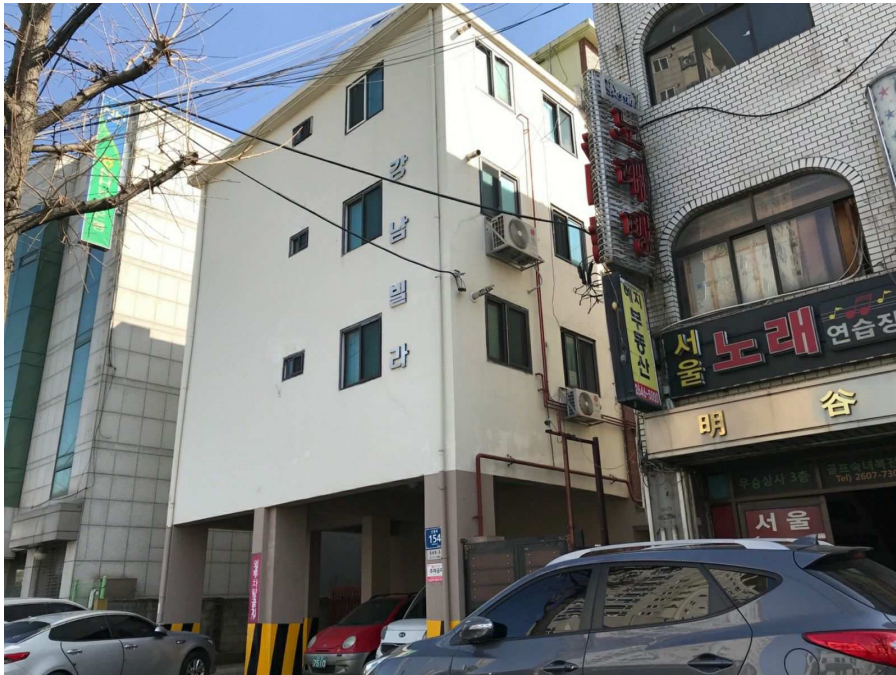
본건 전경(북서측에서 촬영)
