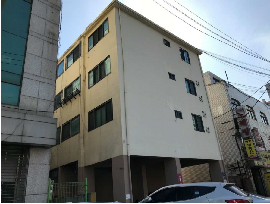
본건 전경(북동측에서 촬영)
